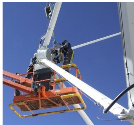
ALMA望遠鏡の副反射鏡でPIのヘキサポッドを設置するエンジニア
